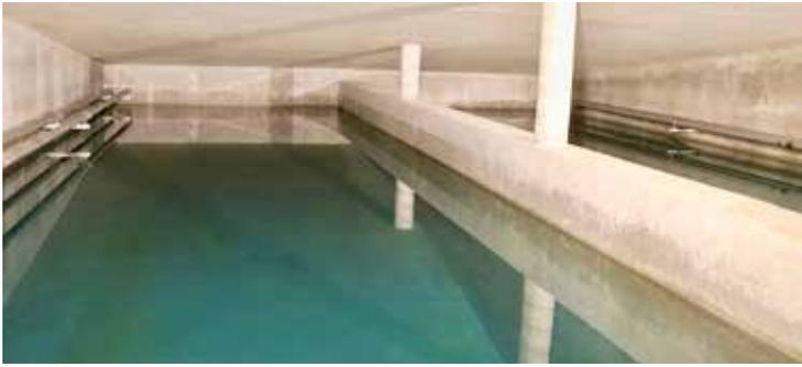
**300 m<sup>3</sup> Trinkwasser fasst der neue Hochbehälter.**
