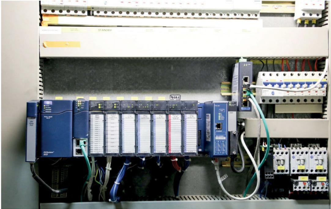
Ein Umstieg von einer 90-30 Alt-SPS von GE Fanuc auf eine Achilles-zertifizierte Hochleistungs-CPU der RX3i-Serie von Emerson gestaltet sich **einfach und unkompliziert**: Im Grunde ist nur der Rückwandbus zu tauschen.
